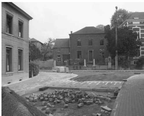
Aménagement du carrefour rue Basse - rue du Centre
